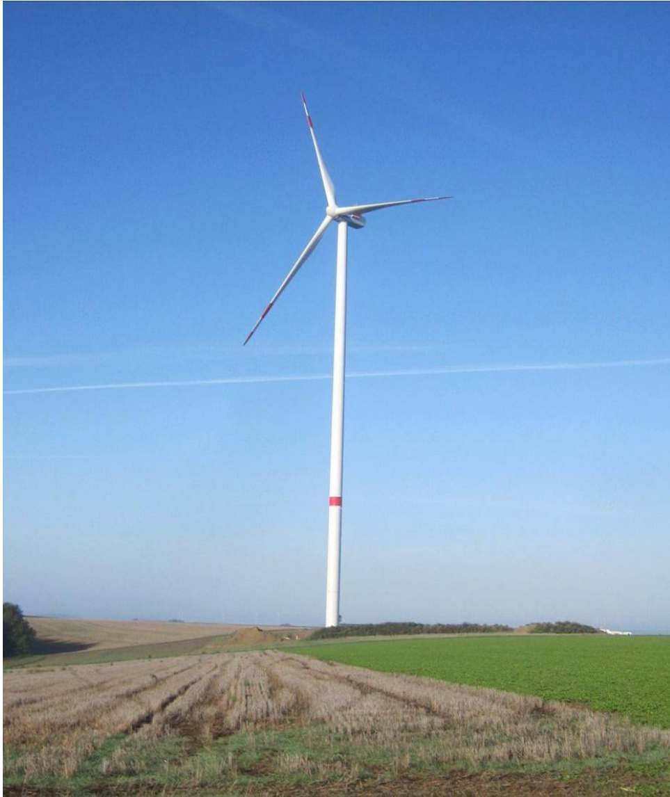
Abbildung 4: Vestas V 112 mit Tageskennzeichnung am Mast und Rotorspitzen
