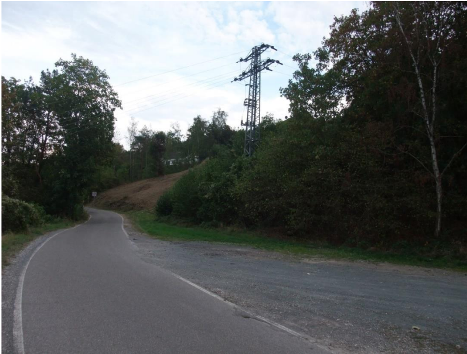
Abb. 13: Ansicht vom Panoramaweg aus Richtung Norden auf den östlichen Teil des Plangebietes (Foto BGHplan, 16.09.2020)
