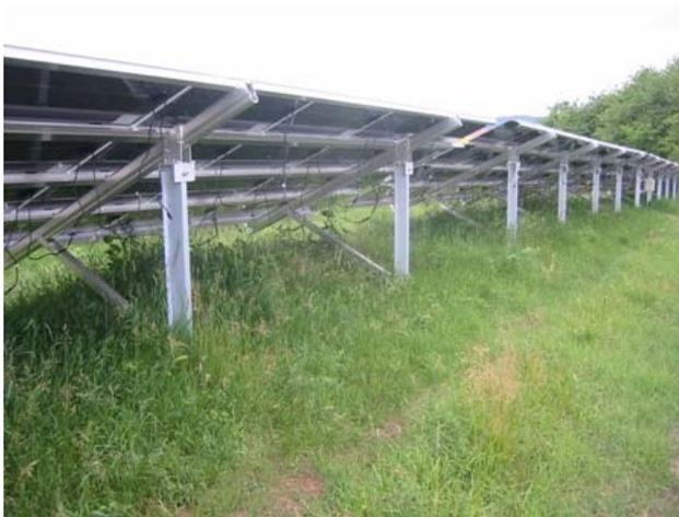
BSP: Unterkonstruktion auf gerammten Stahlpfosten / Stahlkonstruktion
