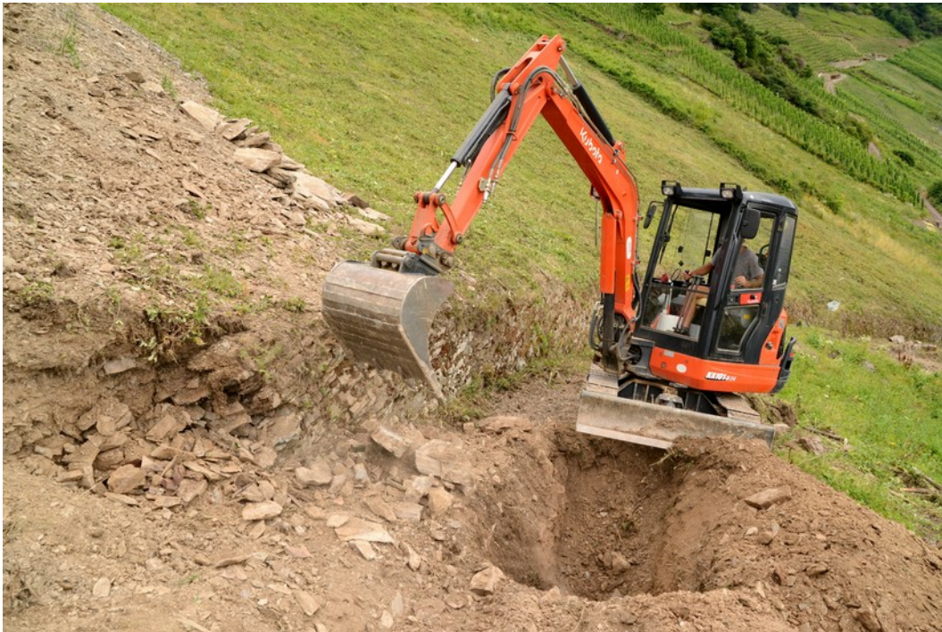
Abb. 8: Mauerabtrag mit Hilfe eines Kleinbaggers.
