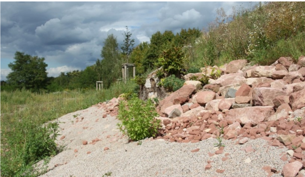
Abb. 6: Steinlinse mit vorgelagertem Sand im Hangbereich als CEF-Maßnahme für Mauereidechsen in Landau.
