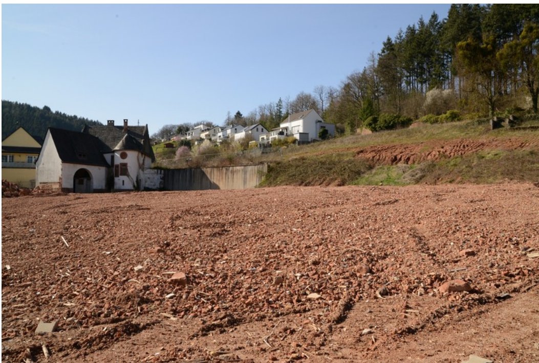
Abb. 1: Blick nach Westen auf den zentralen Bereich des abgerissenen Hauptgebäudes und die Hangbereiche.
