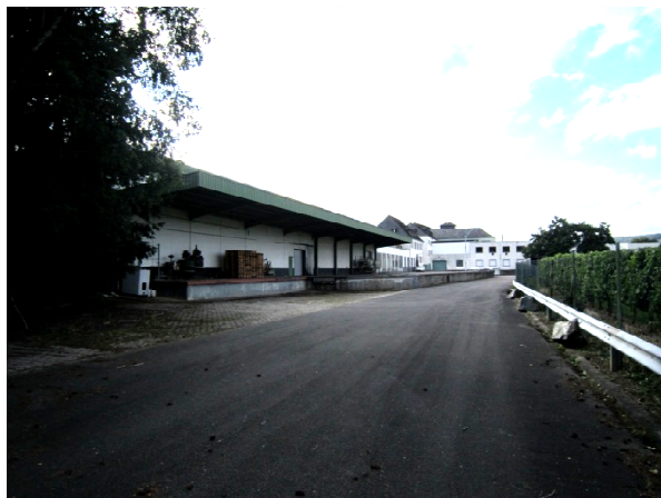
Von der Moselstraße in das Plangebiet hineinführende private Bestandsstraße vor Gebäudeabbruch
