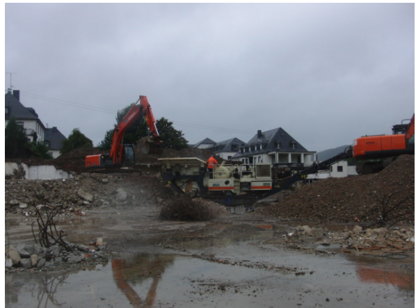
Blick Richtung Nordwesten während des Abbruchs
