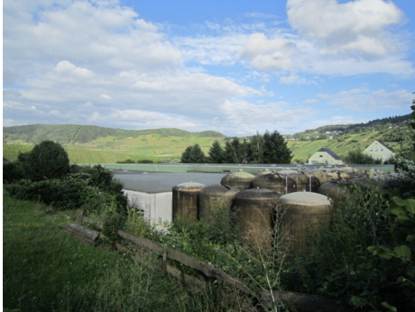
Blick Richtung Osten von der Ausoniusstraße über die Halle vor Abbruch
