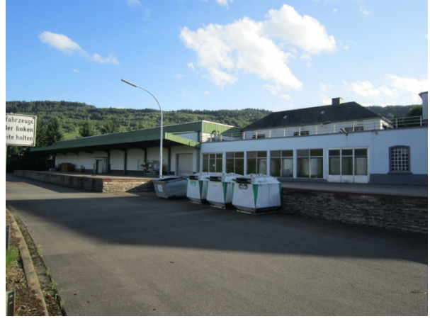
Blick Richtung Süden auf die Bestandsgebäude vor Abbruch
