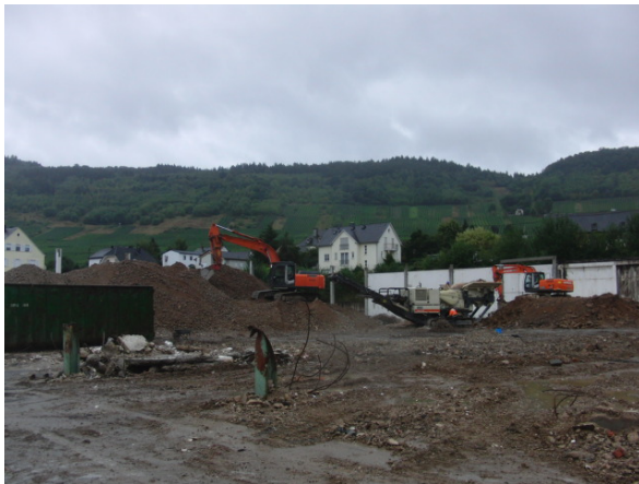
Blick Richtung Süden während des Abbruchs
