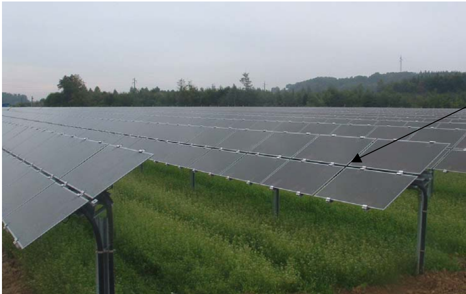
Spalten zwischen den Modulen für abtropfendes Wasser
