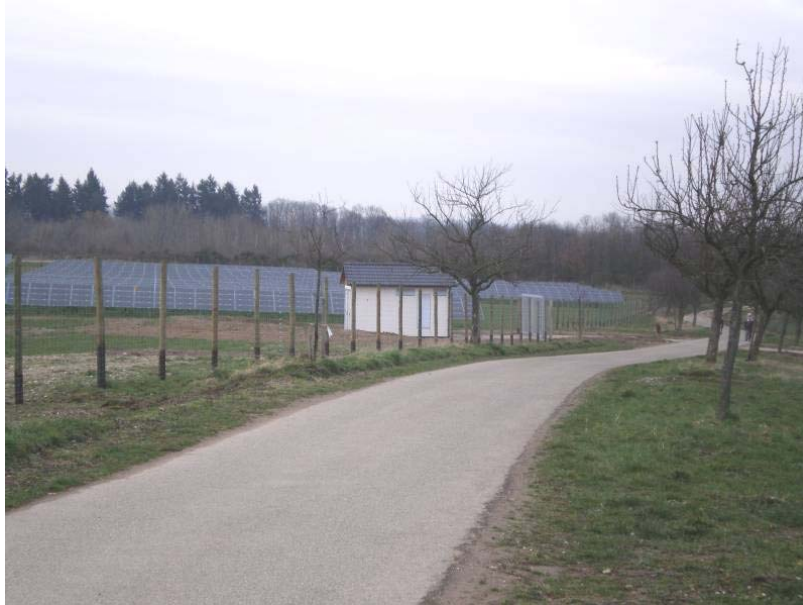
Bsp. baugleiche Anlage
