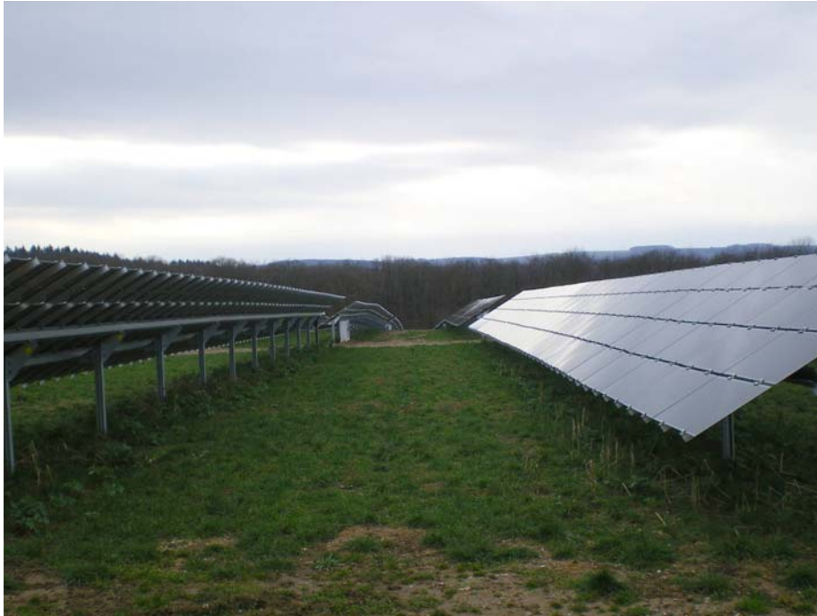
Foto 1 Anlage Ackersberg: durchgehender Unterwuchs, keine Erosion an Tropfkante erkennbar
