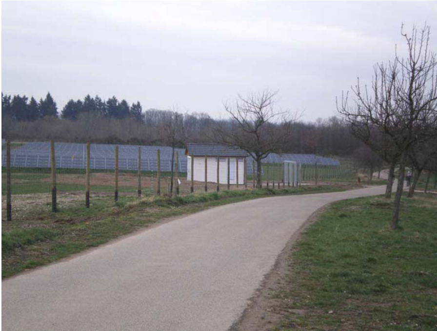
Foto 13. Bsp.: Anlage Ackersberg in Longuich, auch hier wird ersichtlich, dass die Anlage unter dem Horizont und umgebenden Pflanzungen bleibt. (die Sichtschutzpflanzung am Zaun ist noch nicht realisiert)
