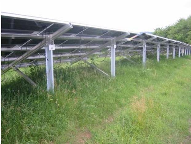
BSP: Unterkonstruktion auf gerammten Stahlpfosten / Stahlkonstruktion
